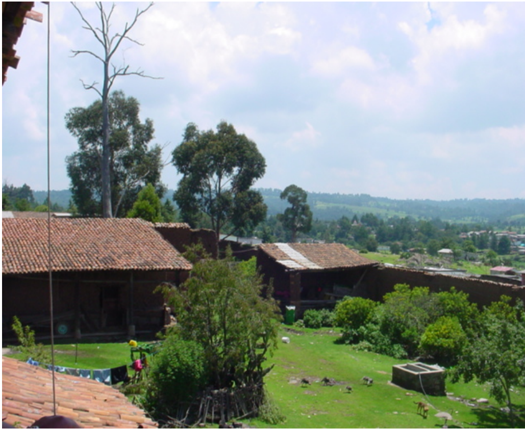
Figura 6: Vivienda de adobe con techo de dos aguas, de teja
