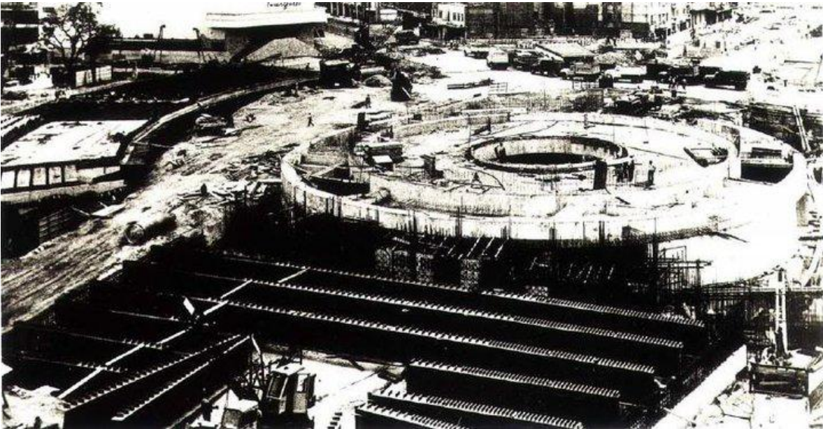
Imagen 10. Construcción de la Glorieta del Metro Insurgentes. 1969. Fuente: ibidem.
