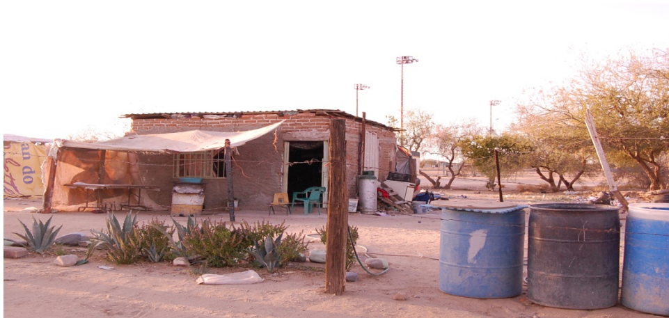
Ilustración 9 Vivienda de La Ladrillera. Al frente tambos para almacenar agua para la casa
