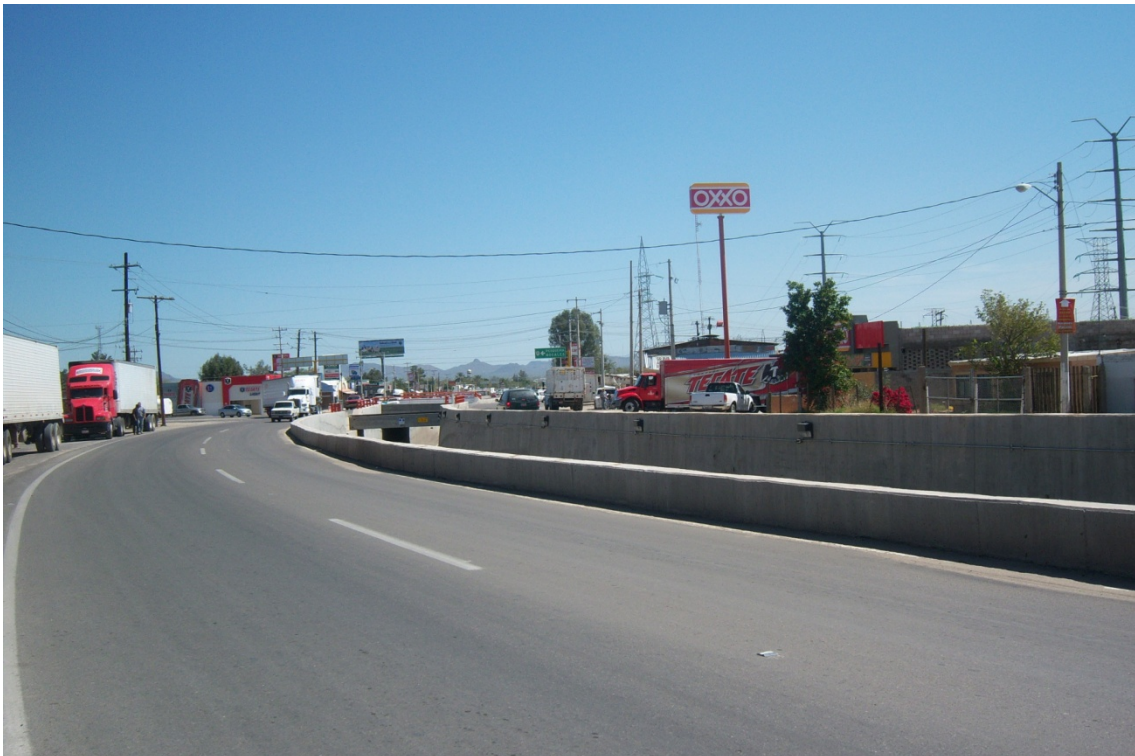
Ilustración 24 Acceso a San Pedro el Saucito por la carretera 14 modernizado en 2007
