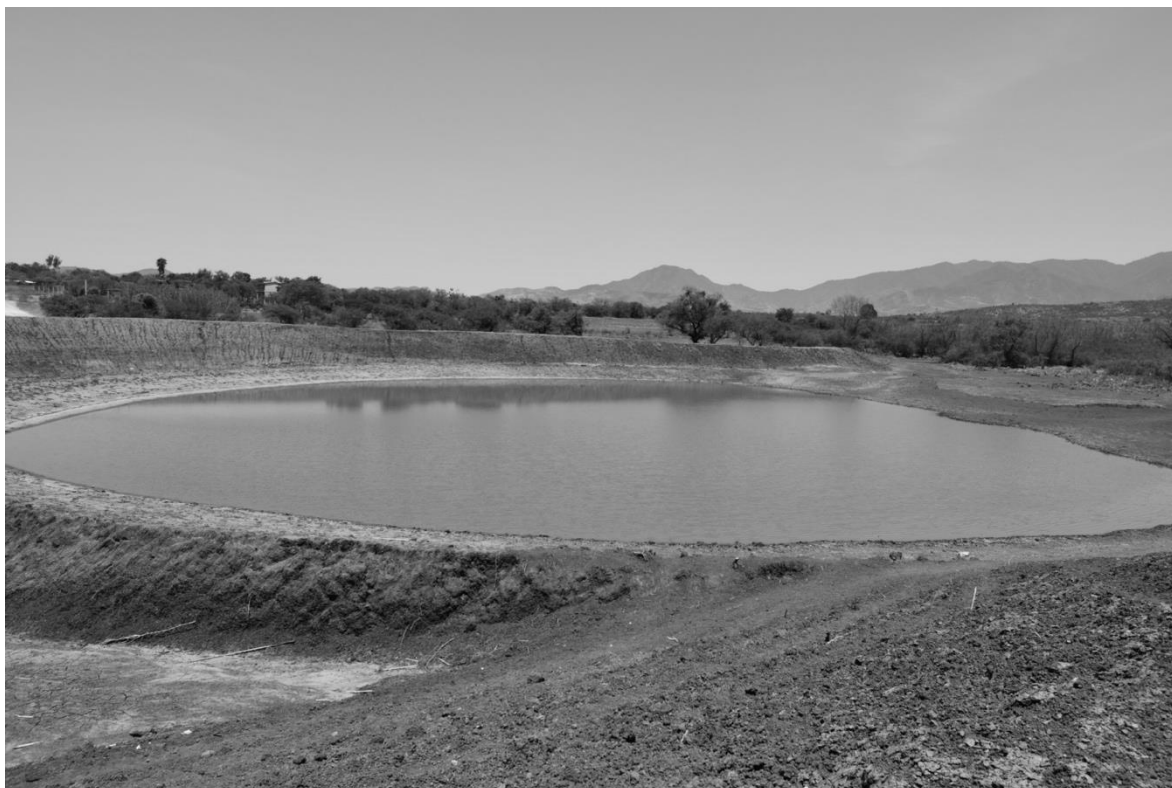
Figura 11. Olla de captación en San Matías Chilazoa.
