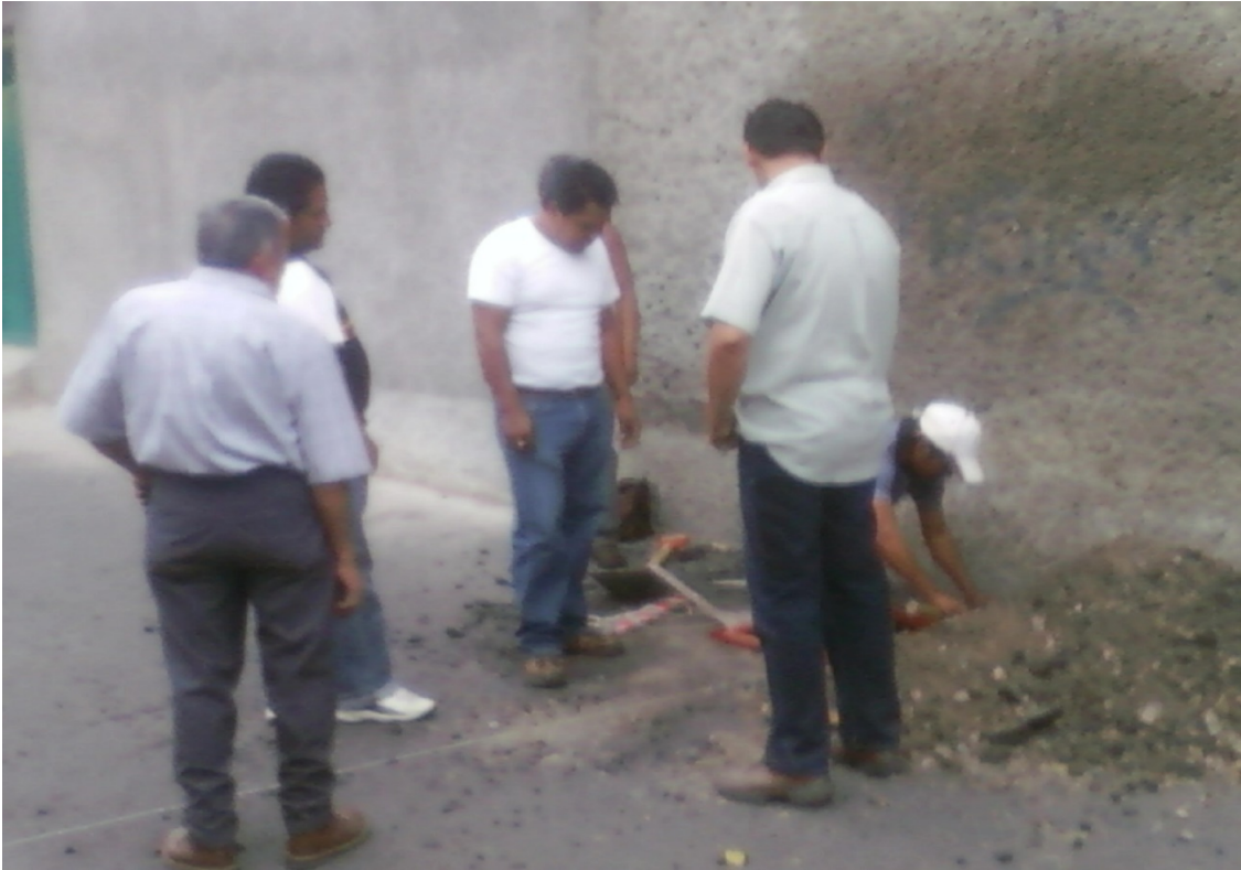
Hombres trabajando para colocar la estructura o postes de la Portada del Niño Barrio de Tlacoapa Mayordomía 2010 – 2011 Mayordoma: Antonia Guerra 30/01/2010 Fotografía del autor.
