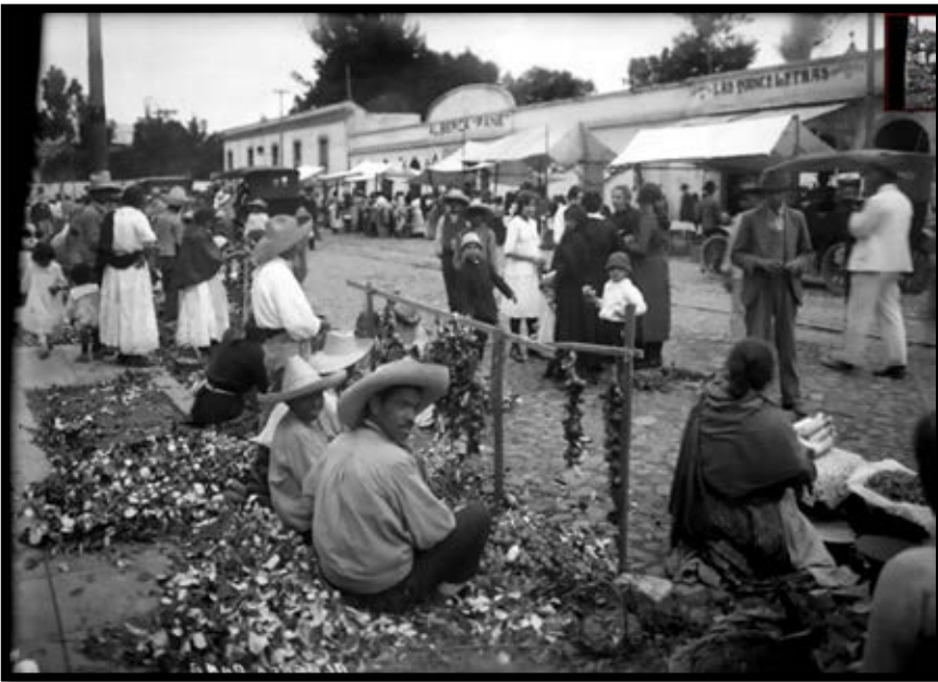
IMAGEN 77. Exterior que presentaba el exterior de la alberca Pane, Colección Archivo Casasola, 1900, Fototeca Nacional.
