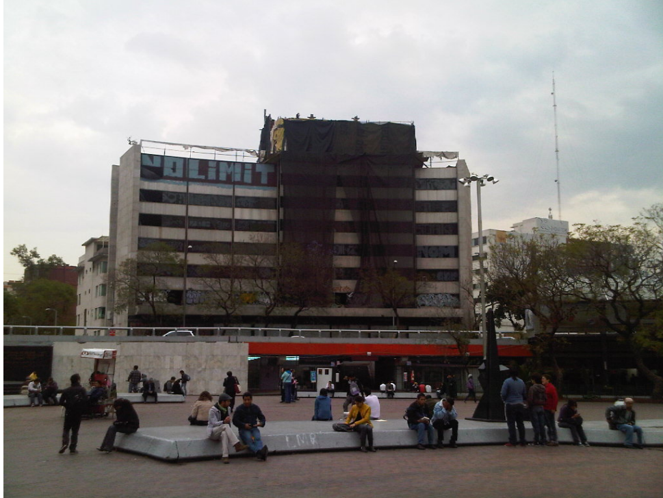
Imagen 8. - Planchas de concreto como asientos. Se advierte también el inicio de las obras de demolición del edificio abandonado. Imagen propia.
