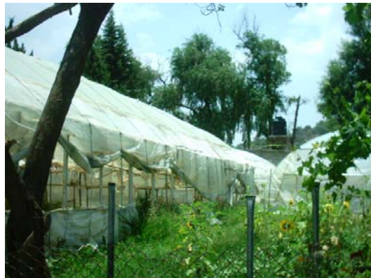
Invernadero de Santa Inés
