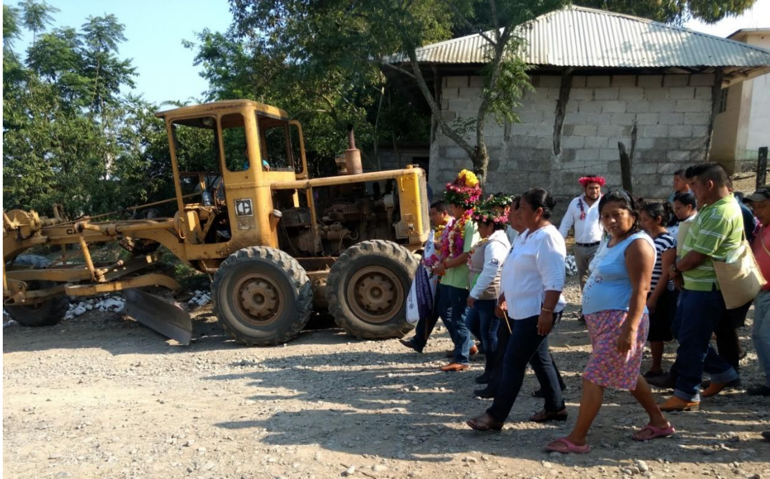
Ilustración 15. Apertura de la rampa que corre de Ixkakwatitla a San Fernando.
