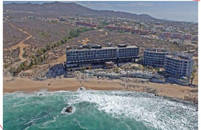
Los edificios fueron construidos con una estructura de concreto reforzado, colado en sitio, cimentación de zapatas aisladas, losas nervadas de entrepiso y muros divisorios de sistemas ligeros
