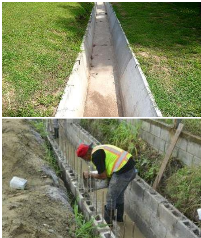
Figura 8.4: a) canal construido con placas de hormigón armado, b) canal construido con block. Fuente a): https://www.agroads.com.ar/detalle.asp?clasi=65256 Fuente b): http://hondudiario.com/2016/12/12/el-proyecto-de-construccion-de-canales-de-aguas-lluvias-en-sps-en-etapa-final/
