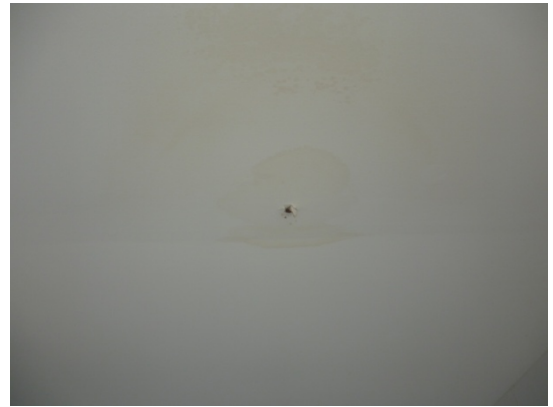
Foto 3 y 4 .- Se detectaron algunas infiltraciones en la zona de recepción de documentos. Sugerimos verificar y revisar para no comprometer las luminarias.
