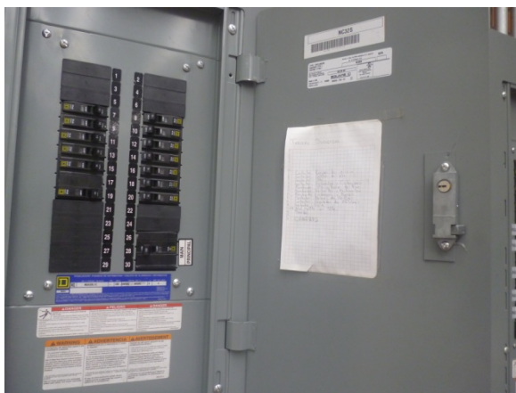
Foto 2.- Sugerimos etiquetar los tableros de forma que no se rompa o se borre la información.
