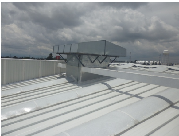
Foto 5 y 6 .- En las siguientes fotos se observa que los ventiladores instalados en la techumbre no se encuentra ajustado de manera adecuada (Tornillo y tuerca mal alineado y forzado)
