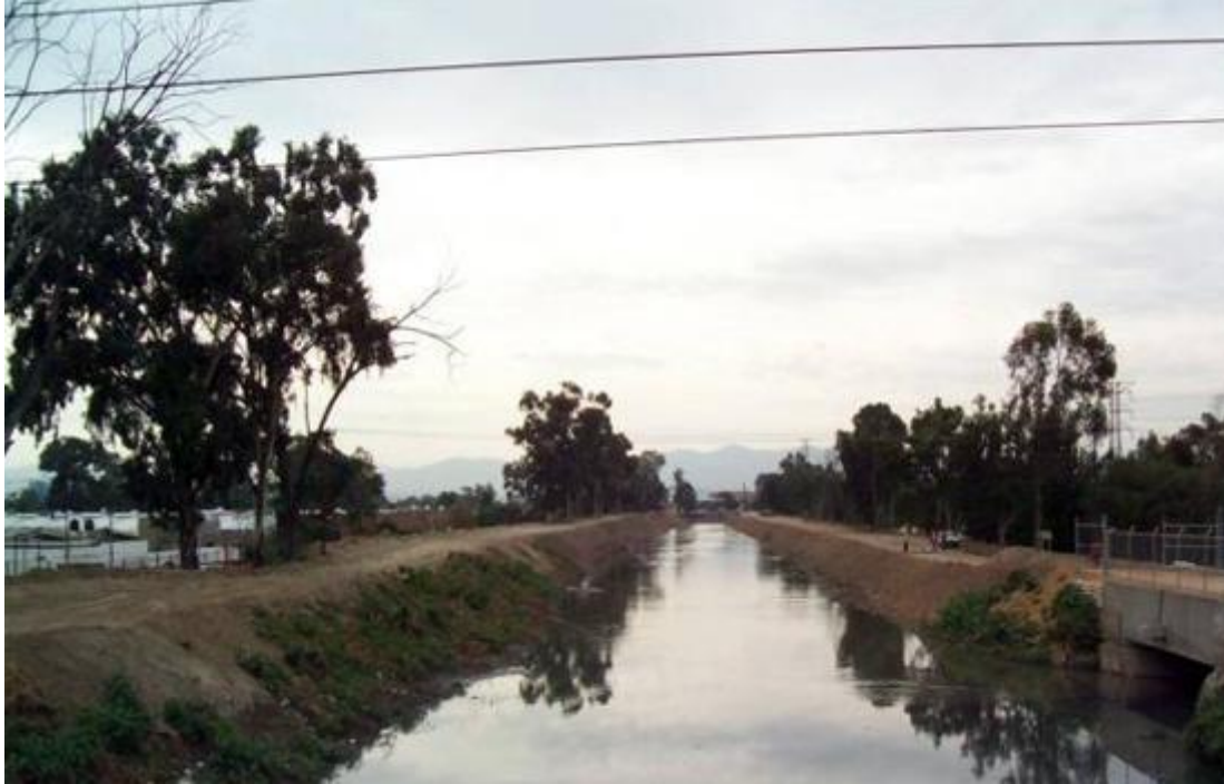
Ilustración 4-2: Canal abierto de aguas negras “Rio de los Remedios” Fuente: Documentación del proyecto
